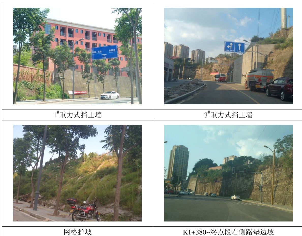
图 5.3 典型路段边坡实景
