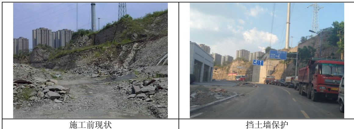
图 7.1 和顺路电力构筑物设施保护措施
